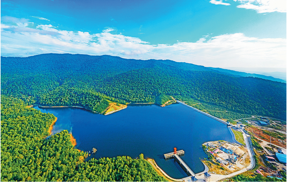
吉林敦化抽水蓄能电站
