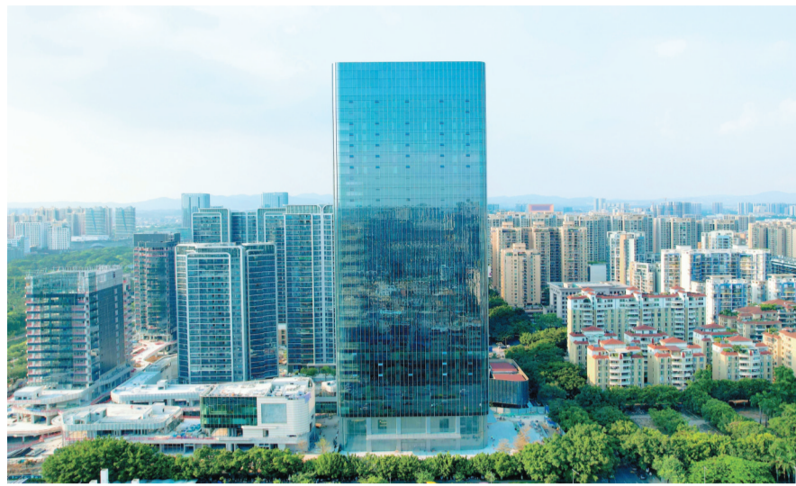
广州大湾区科创中心项目 水电九局 提供
