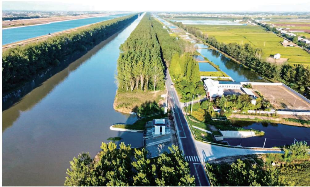
图为苏北灌溉总渠堤防加固工程滨海段水电基础局提供
