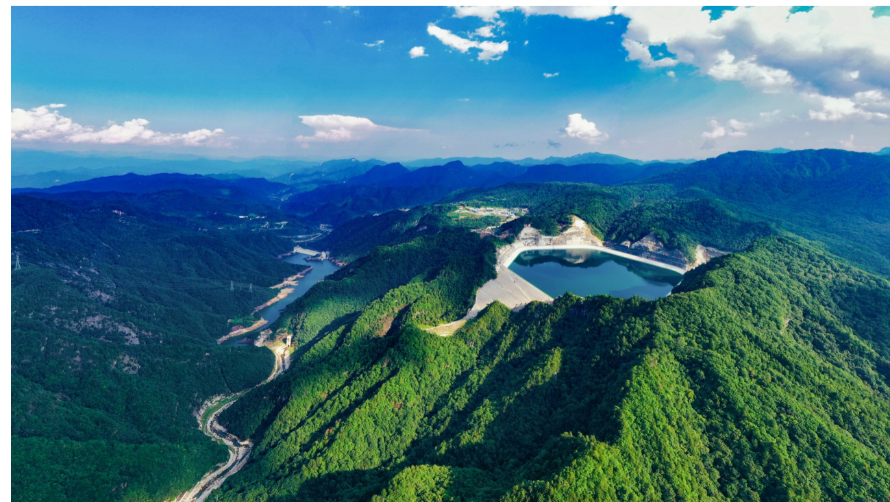
陕西镇安抽水蓄能电站 陈俊 摄
