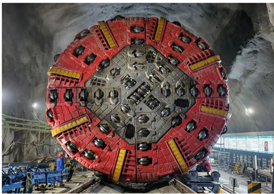
图为超大坡度斜井可变径硬岩掘进机“天岳号”TBM 水电八局 提供
