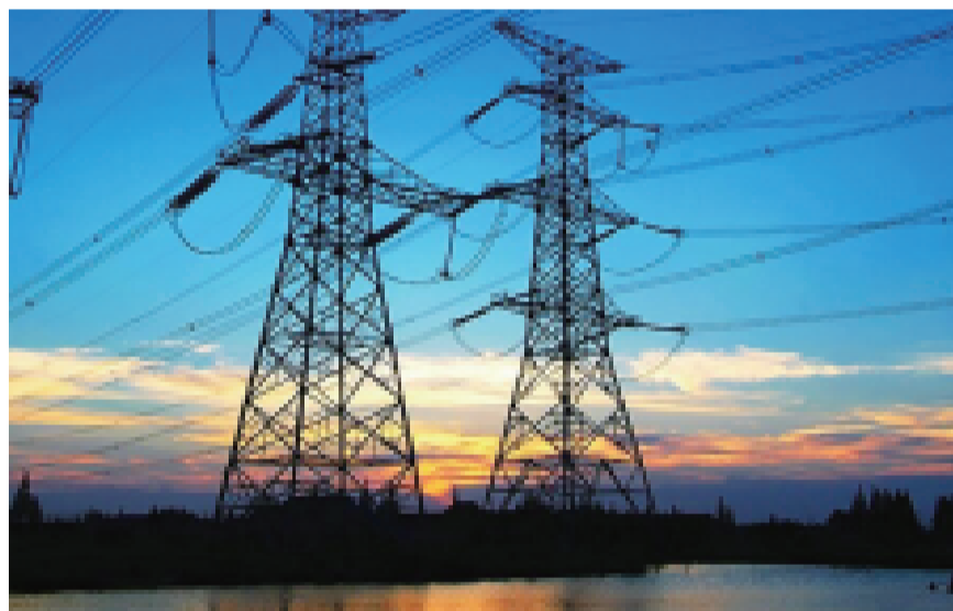
湖北装备公司承建的国网武汉东湖高新公司110千伏线路改迁工程。
