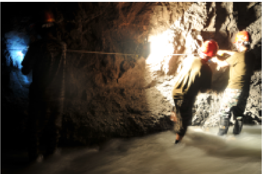
突击队员在洞内紧张施工。 冯进杰 摄
