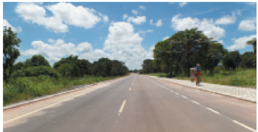
水电四局承建的马兰热STP道路形象。
