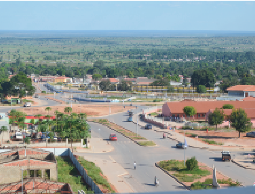
水电四局承建的马兰热RIC道路施工全景。
