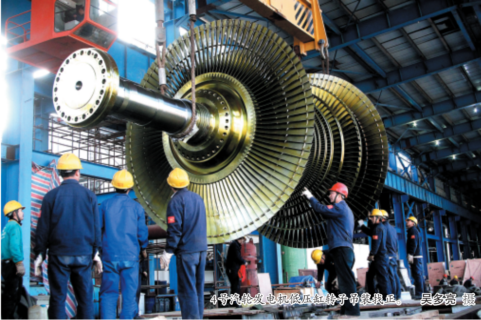
4号汽轮发电机低压缸转子吊装校正。 吴多窈 摄
