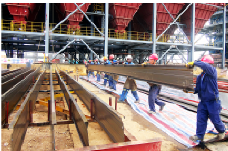
↑阳极板人工放置。 山东电建二公司马二朋摄于赞比亚曼巴电站项目
