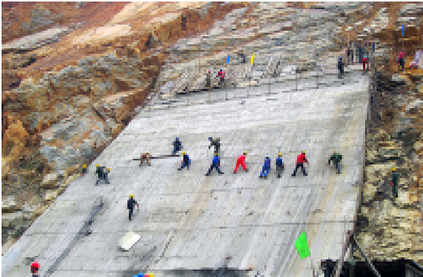
↑峭壁上作画。水电基础局曹佳林摄于云洞水库项目
