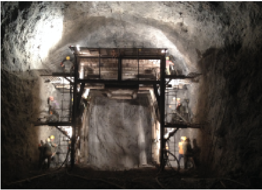
应急泄洪洞施工。朱 磊 摄
