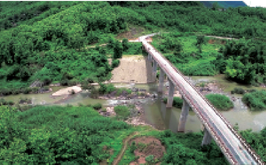
为当地修建的交通桥
