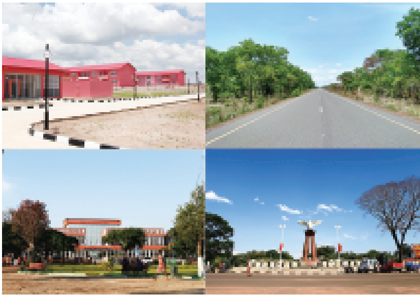
十年来,十三局在安哥拉承建的部分基础设施项目。 十三局提供
