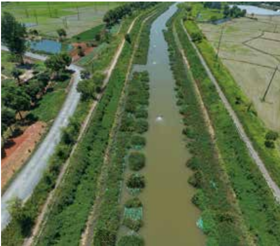
治理后的桐溪河实景航拍图
