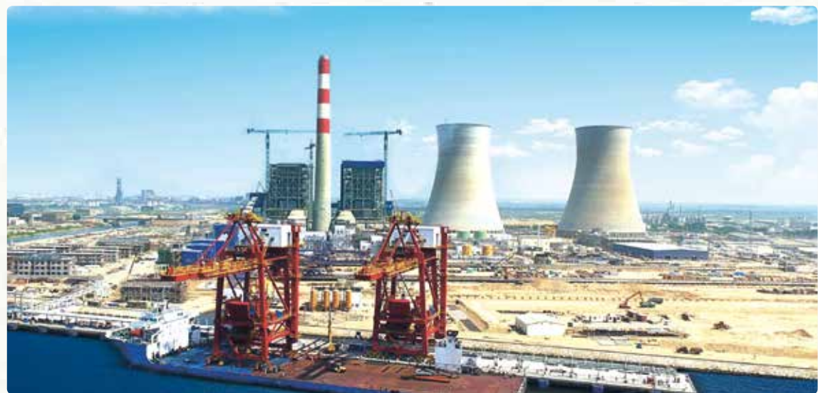
卡西姆港燃煤电站——“中巴经济走廊”首个落地的大型火电项目。被巴基斯坦政府称为“一号工程”。该项目于 2015 年 5 月正式开工，2018 年 4 月进入商业运行，是带动中国技术、中国标准、中国装备和中国文化“走出去”的示范项目。
