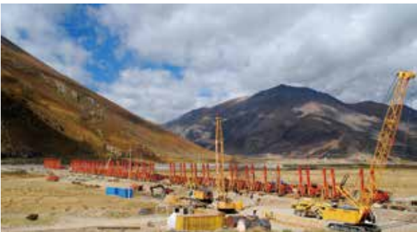
西藏旁多工程（防渗墙深 201m）
