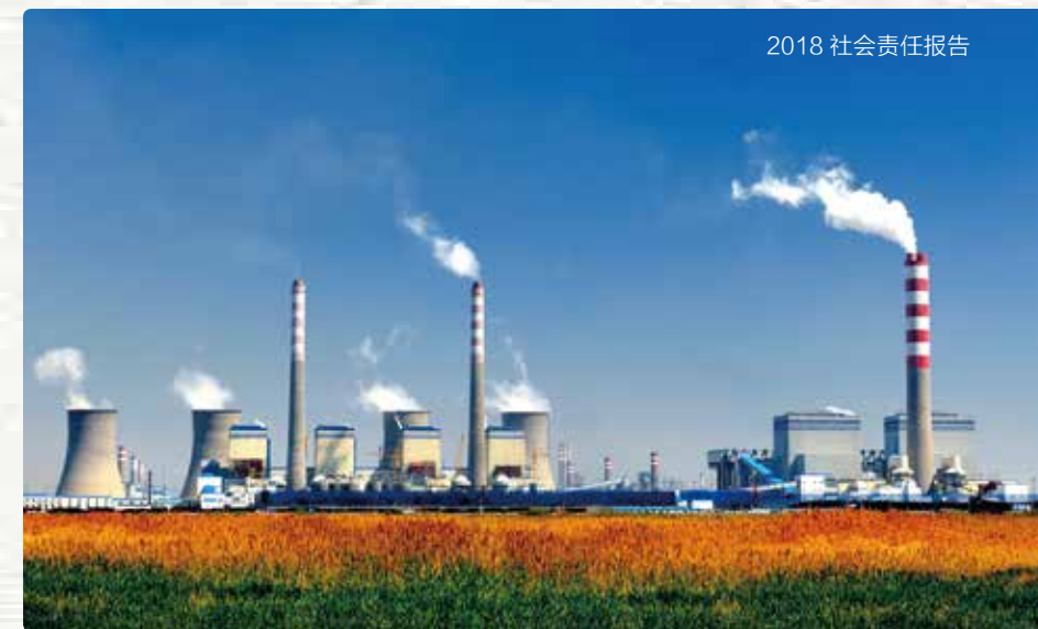
新疆农六师电厂 ——我国火电单机容量最大的 1100 兆瓦超超临界机组。
