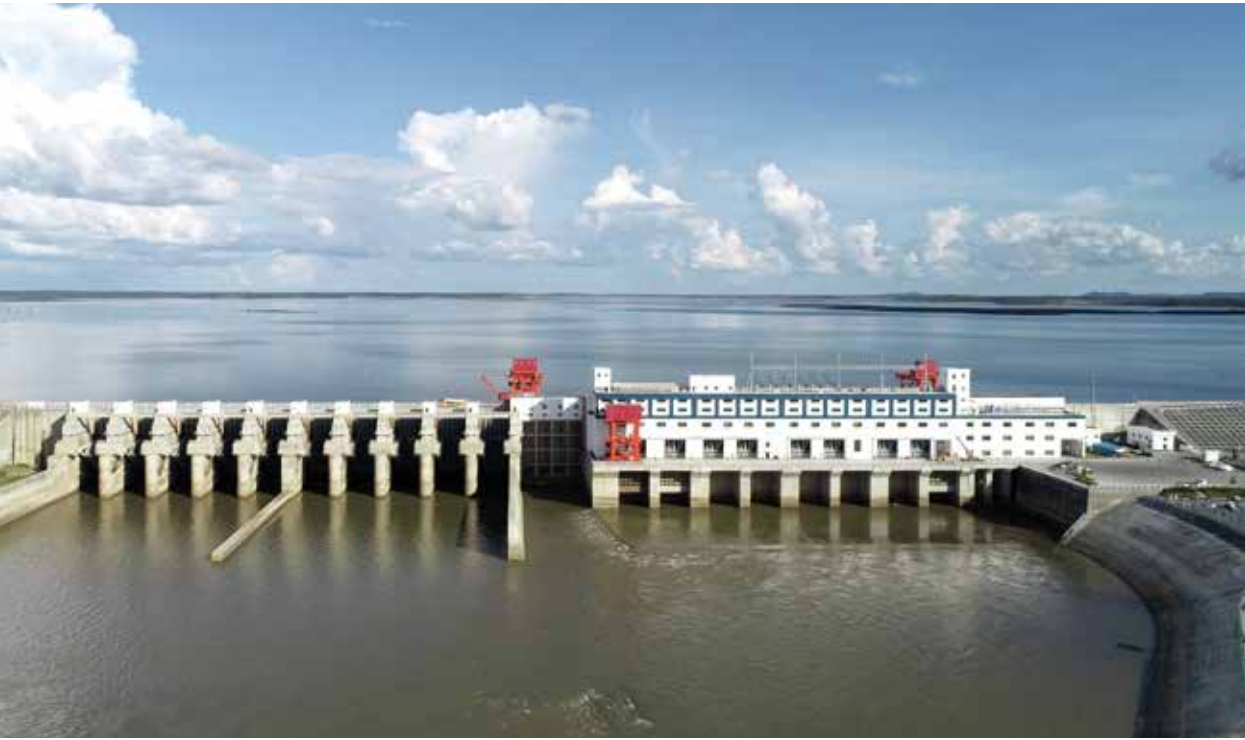
柬埔寨桑河二级水电站
