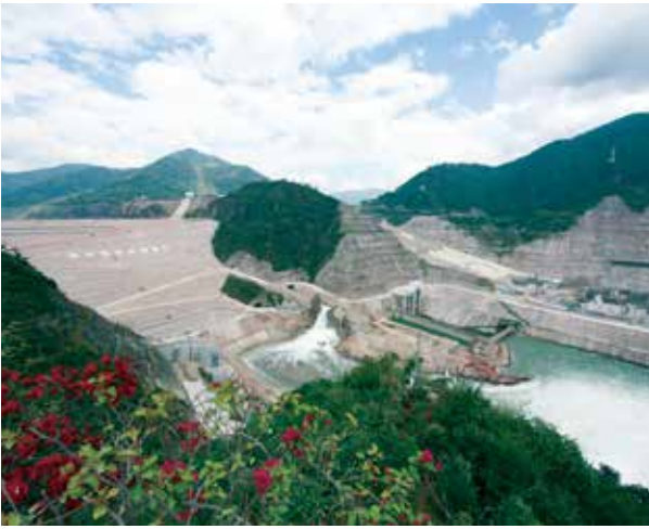
糯扎渡水电站
