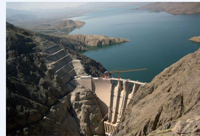
方米，可为 191.9 万英亩农田提供灌溉用水；大坝坝高 133 米，为巴基斯坦第一座碾压混凝土重力拱坝，每年可减少大坝下游居民因洪灾造成的损失约 260 万美元；水电站装机容量 1.7 万千瓦，可为当地 2.5 万户居民日常生活供电。
